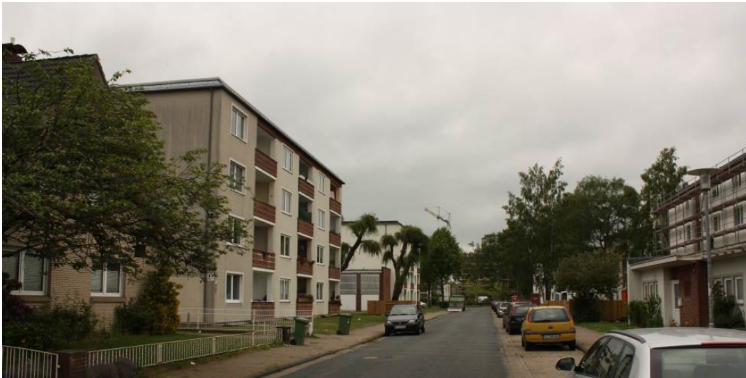
Abb. 3: Hermannstädter Straße. An diesem Standort im Stadtnorden wurde eine vergleichsweise hohe Anzahl von Brutpaaren an benachbarten Mehrfamilienhäusern beobachtet. Die Brutplätze befinden sich hinter der Dachverblendung zwischen dem Mauerwerk der viergeschossigen Gebäude. In direkter Nachbarschaft dieser Gebäude konnte zudem eine Mauerseglerbrut in einem Starenkasten an einem Baum beobachtet werden.
