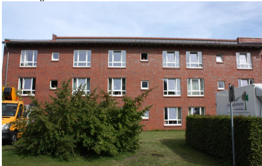
Abb. 8: Gertrudenheim Oldenburg, Anbringung von 12 Kästen, Ausrichtung West.
