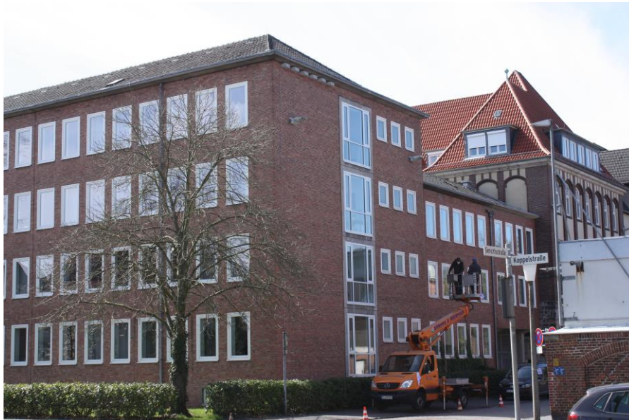
Abb. 16: Oberlandesgericht Oldenburg, Anbringung von 6 Nistkästen im Außenbereich.
