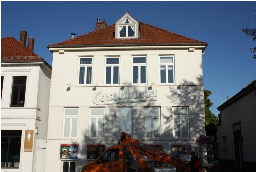
Abb. 13: Casablanca Kino, denkmalgeschütztes Gebäude, Anbringung von vier Nistkästen.
