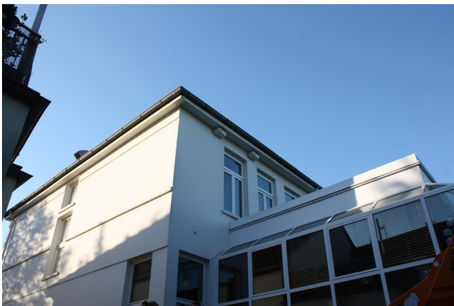
Abb. 14: Casablanca Kino, Gebäuderückseite, denkmalgeschütztes Gebäude.
