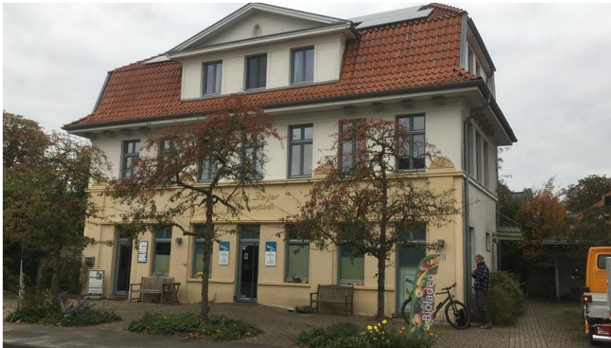
Abb. 11: Bürogebäude des Architektenteam Team 3, Anbringung von 13 Nistkästen.
