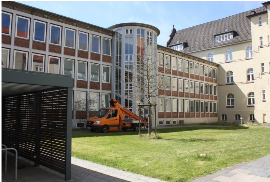
Abb. 15: Oberlandesgericht Oldenburg, Anbringung von 18 Nistkästen im Innenhof.
